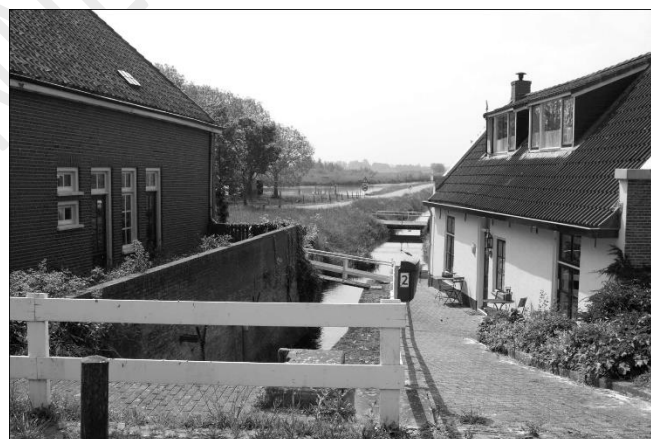
Achter het sluishuis bevindt zich ook nu nog een uitwateringssloot. Net zoals de vroegere spuisluizen.
