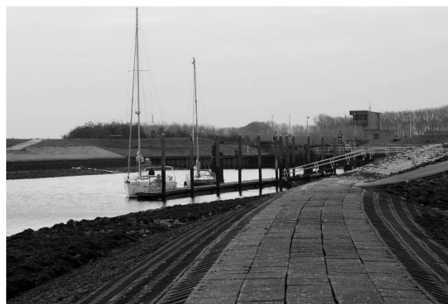
De Nieuwe Sluis met voorhaven.
