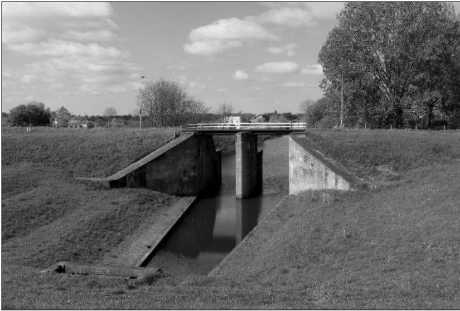
De Inundatiesluis gezien vanaf de zijde van de Waal.
