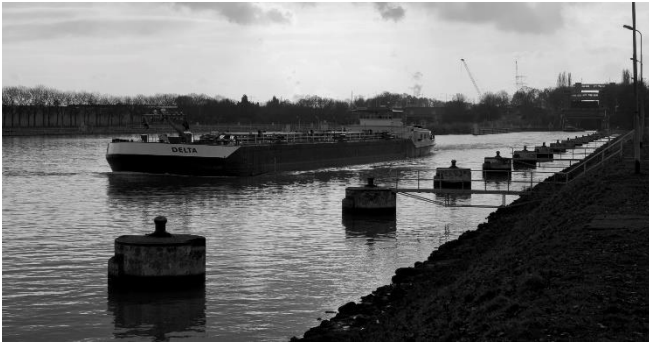
Sluiscomplex bij Born.
