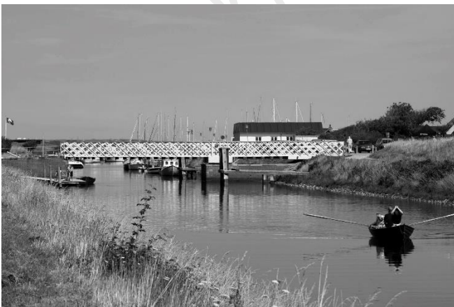
Fraaie gietijzeren brug naar het kanaalhuis bij Løgstør.
