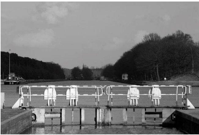
De sluis bij sas 4.
