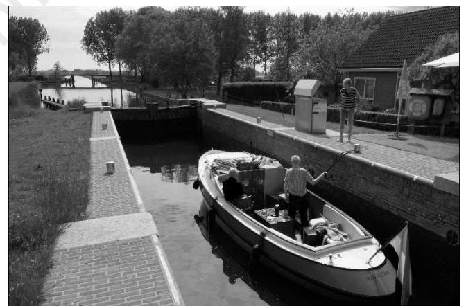
De Pondscoekersluis in gebruik.
