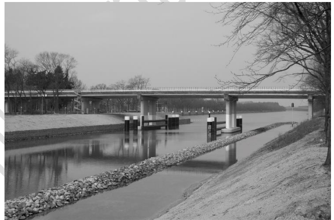
Nieuwe vaargeul bij de keersluis Malden.
