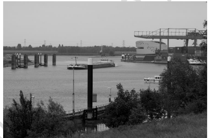
De monding van het kanaal in de Waal met op de achtergrond de nieuwe verkeerspost.
