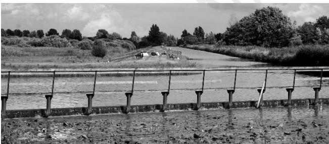
Het Waterleidingkanaal loopt via een duiker onder het Tienhovens Kanaal door.
