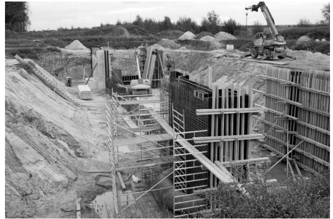
Bouw van de spaarsluis bij Klazienaveen in volle gang.
