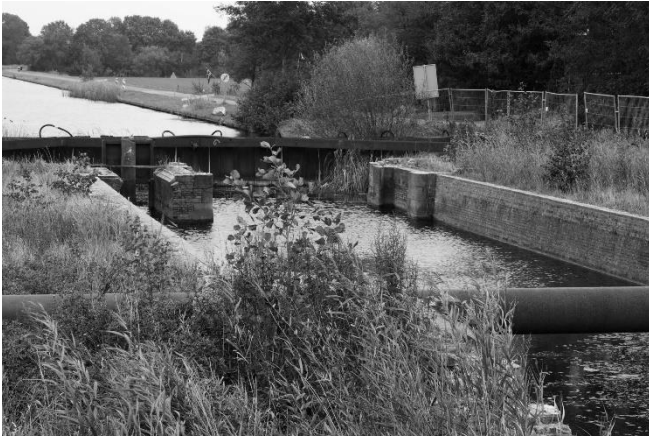
Uitgraven van de oude sluizen in het Polderhoofdkanaal.
