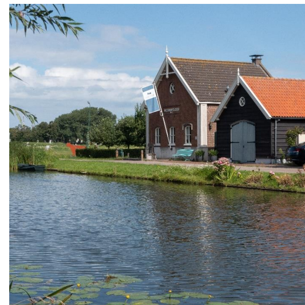
Boven: Het Noordpoldergemaal van Muiden.
