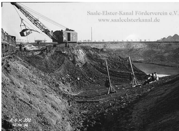
Onder: Werk aan het Saale-Elster-Kanal in 1936 (fotoarchief: Saale-Elster-Kanal Förderverein e.V.).
