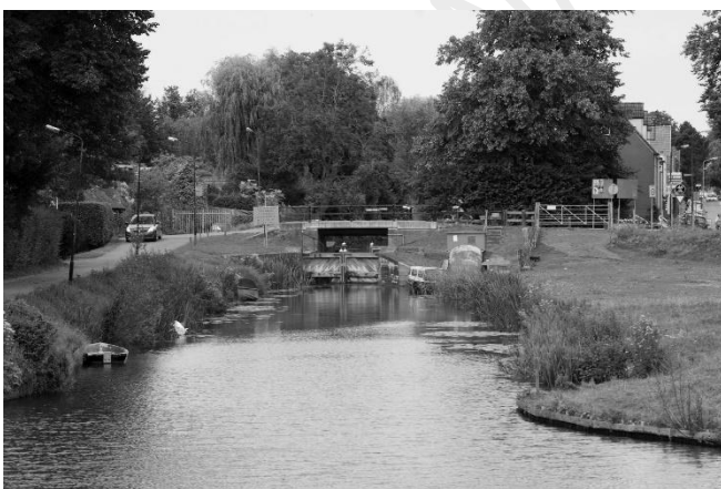
De 's-Gravelandsche Vaart met op de achtergrond de gerestaureerde Zuidersluis.
