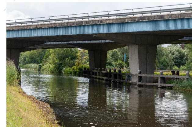
Boven: Viaduct van de rijksweg A1 met daaronder een kamaal.
